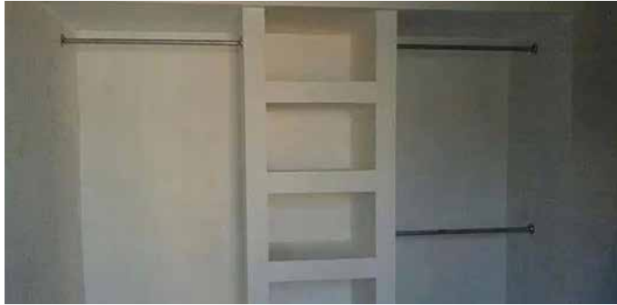
Figura 10. Armarios fijos de concreto
