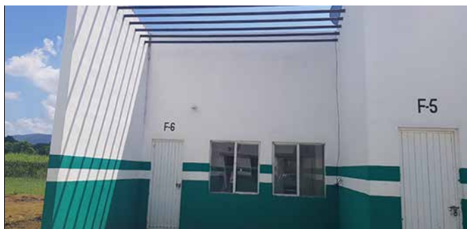
Figura 1. Paredes altas, de más de 2.5 metros
